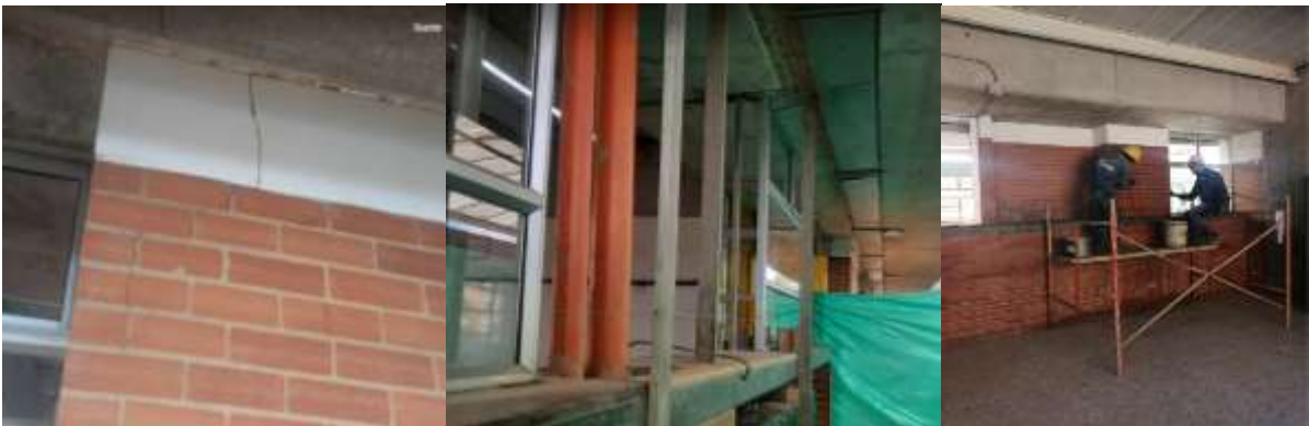
INTERVENCION AULAS 304, 305 Y 306
