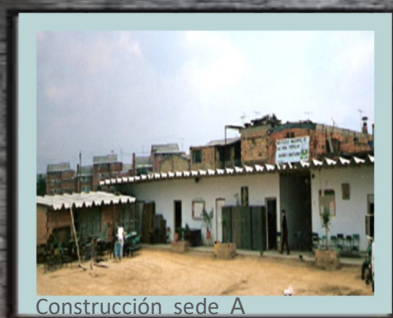
Construcción sede A
