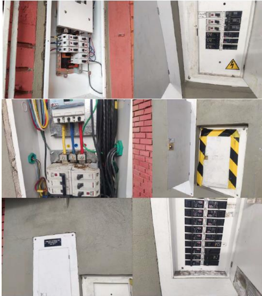
FOTOS DE LOS TRABAJOS EJECUTADOS EN TABLEROS
