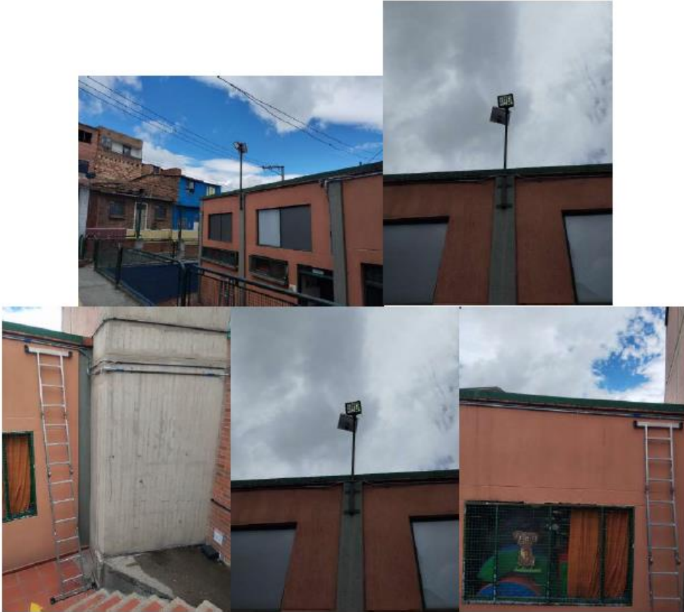
FOTOS DE LOS TRABAJOS EJECUTADOS DEL REFLECTOR SOLAR
