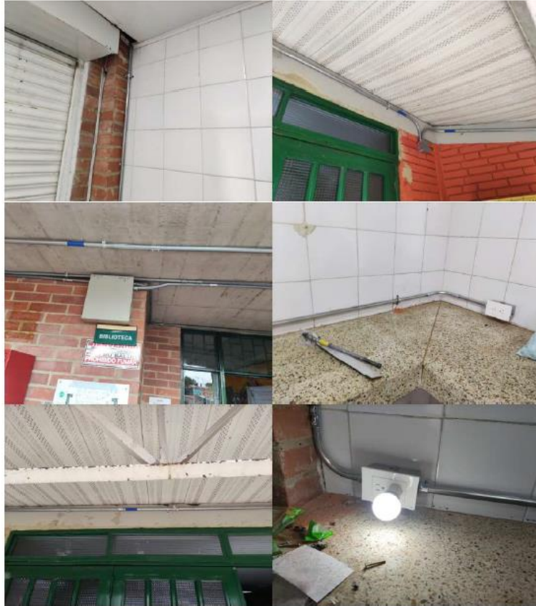
FOTOS DE LOS TRABAJOS EJECUTADOS EN TOMAS PARA HORNOS
