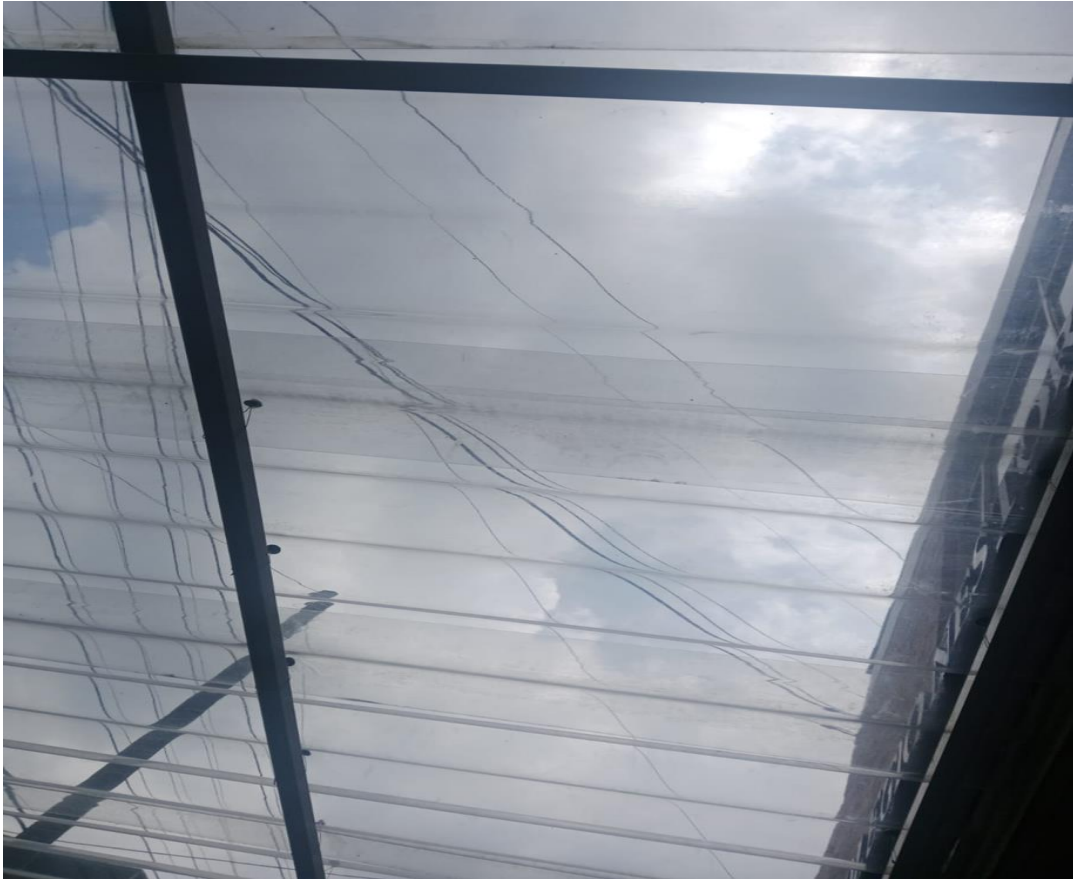
Techo de la sede C
